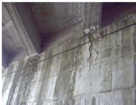
Cls in distacco con armatura scoperta
