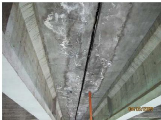
Efflorescenze su sbalzo Macchie di umidità su soletta Tracce di scolo su travi
