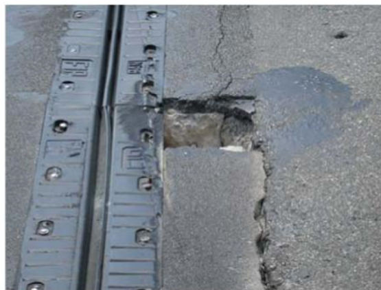
Rottura parziale giunto a pettine Distacco massetto Distacco rivestimento in gomma
