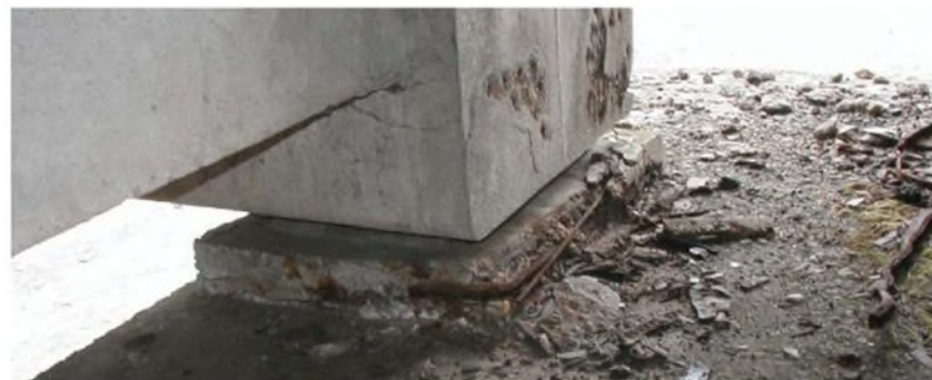
Ammaloramento calcestruzzi
