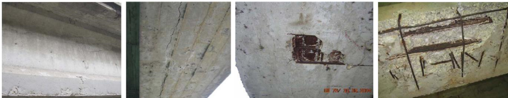
Lesione su anima Lesioni sul bulbo Guaine in vista Guaine degradate e fili ossidati in vista
