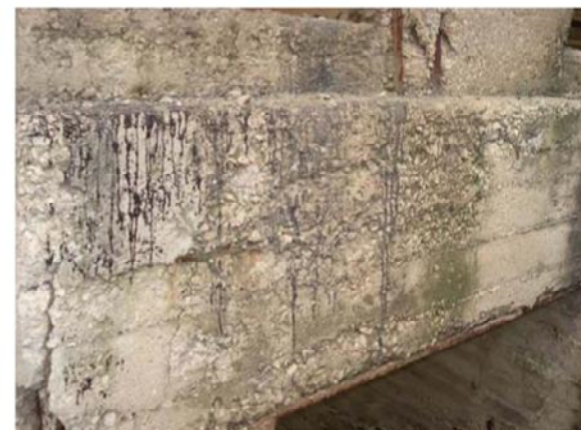
Correlazioni: Cls ammalorato e distaccato con armatura scoperta (V.tto Alento)
