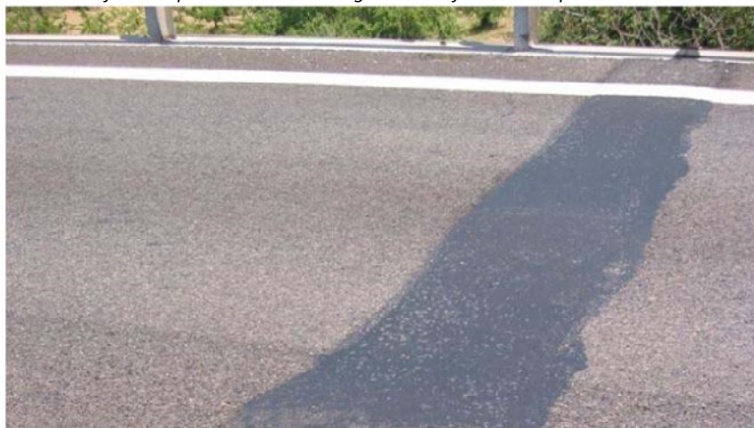
Deformazione giunto a tampone Distacco giunto a tampone
