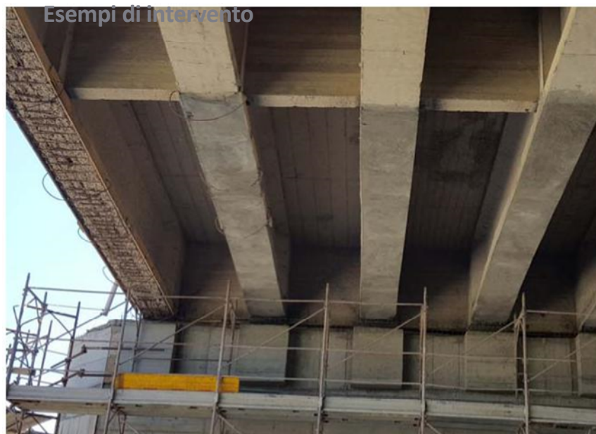
Ripristino di Travi con Malta MT1.
