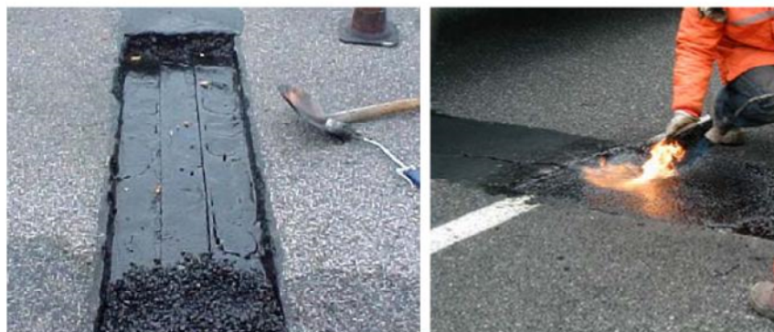
Ripristino giunto a tampone viscoelastico
