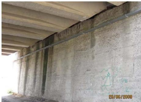
Cls dilavato Cls ammalorato in superficie Cls con ammaloramento medio
