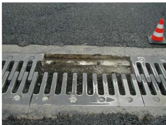
Rottura parziale giunto a pettine Distacco massetto Distacco rivestimento in gomma
