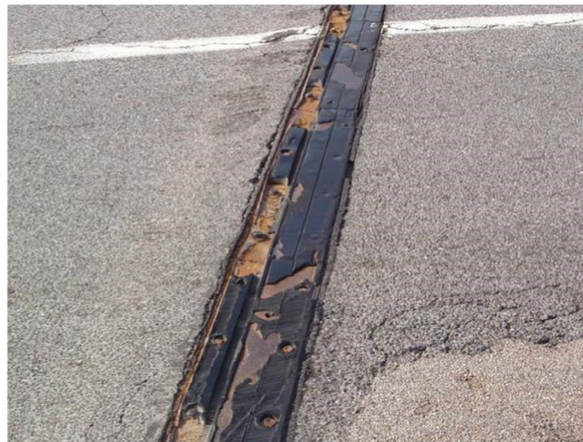
Rottura totale del giunto acciaio - gomma
