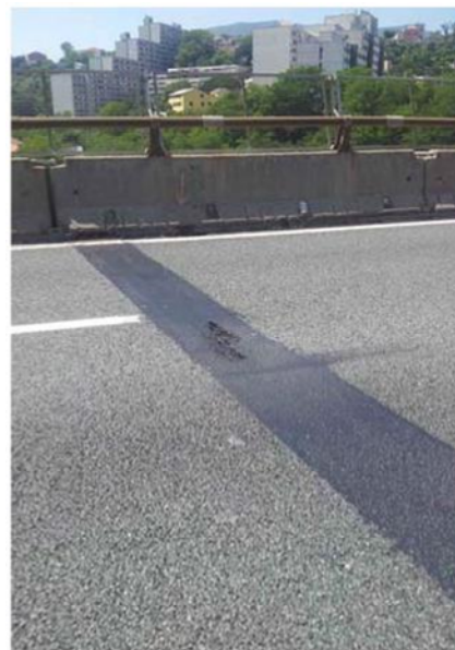
Rottura localizzata del giunto a tampone
