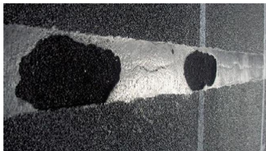
Rottura localizzata del giunto a tampone
