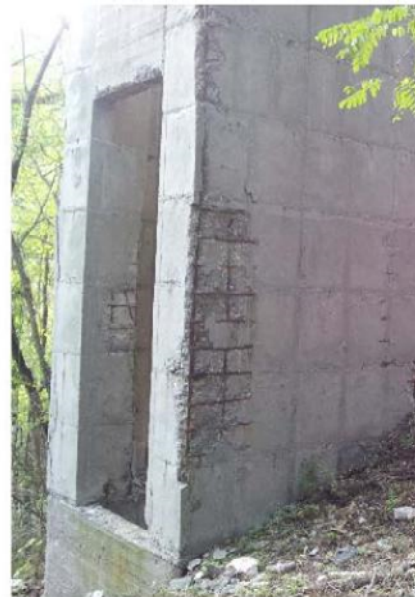
Cls in distacco con armatura scoperta
