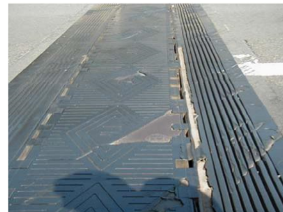
Rottura totale del giunto acciaio - gomma
