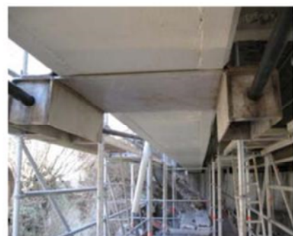
Deviatore in acciaio Blocco in acciaio di testata
