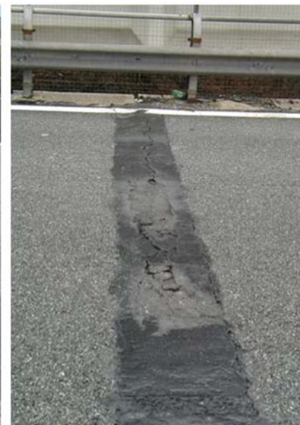
Rottura estesa del giunto a tampone
